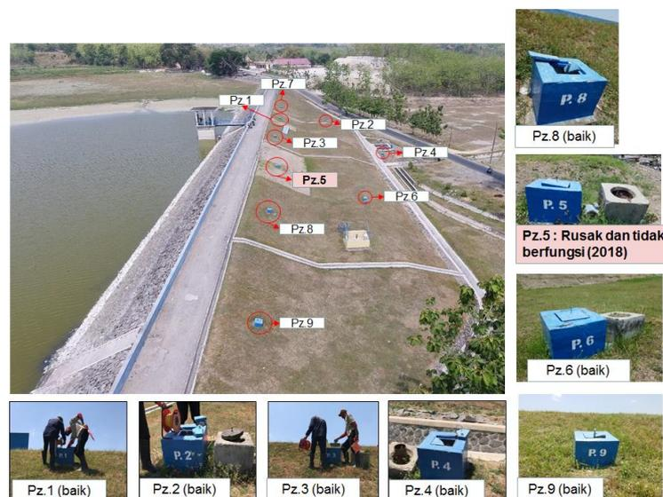
**Gambar 16. Instrumentasi Bendungan (Piezometer)**
