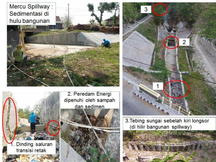
**Gambar 15. Bangunan Pelimpah (*Spillway*)**
