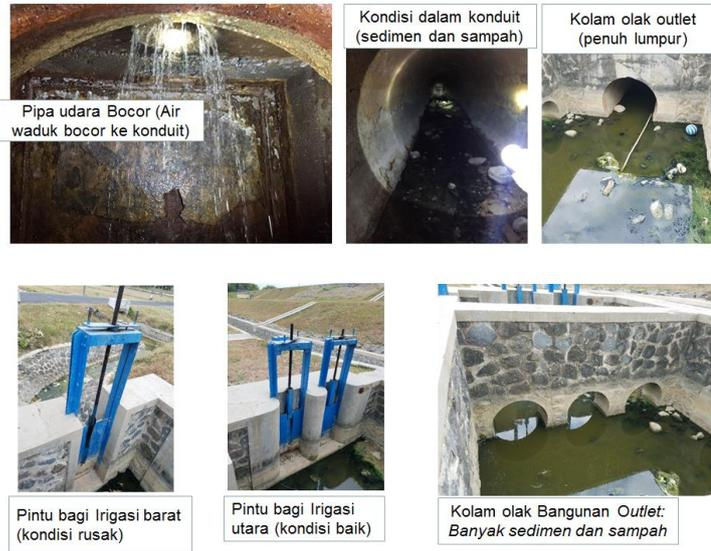
**Gambar 14. Bangunan Intake, Kolam Olak, dan Pintu Pembagi**
